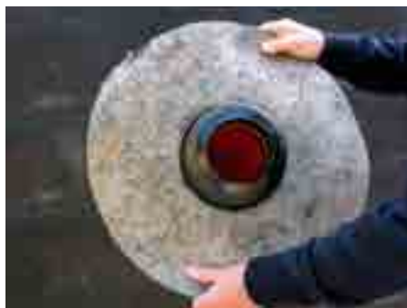
2. Пъха се битумния преход в тръбата
